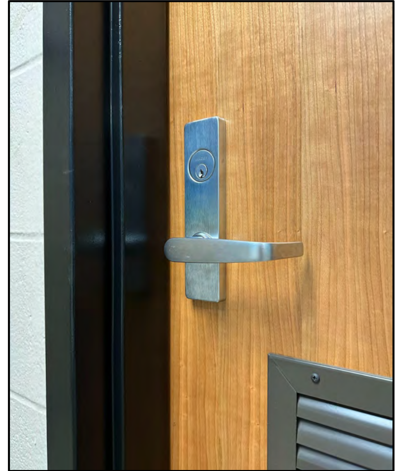
New doors & ADA hardware
