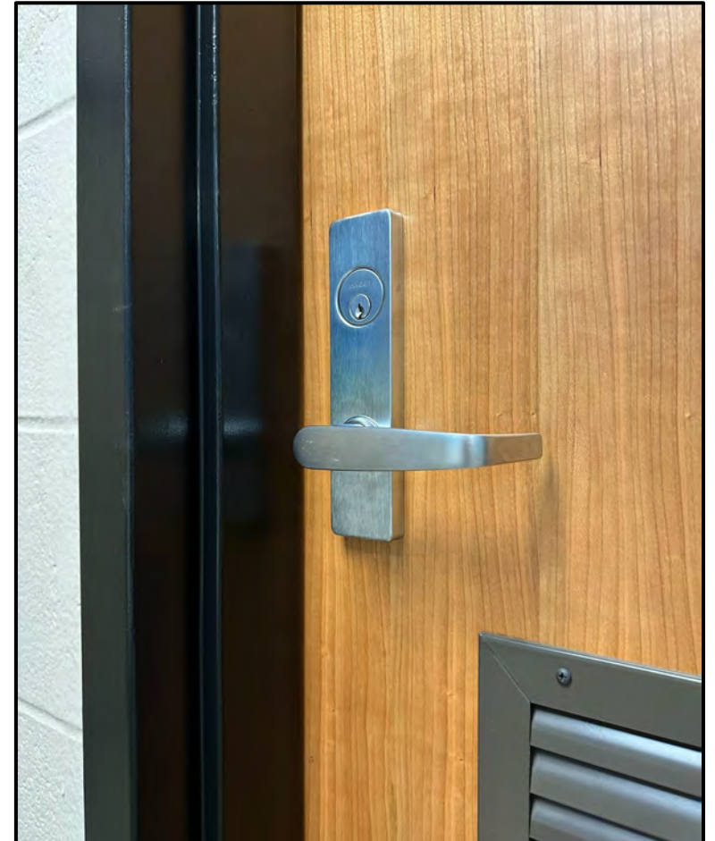
New doors & ADA hardware
